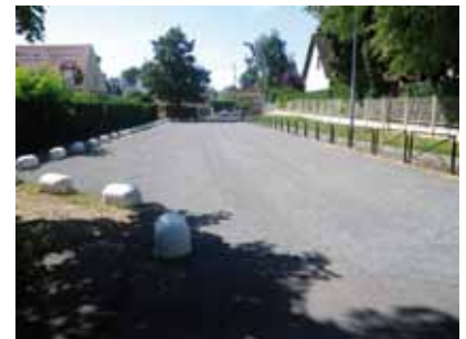
4 - Réfection du parking
