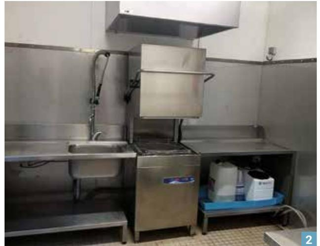
**2 Restauration collective des Érables.** Rénovation de la cuisine par le service technique en installant des protections murales contre les projections d'eau et de vapeur.
